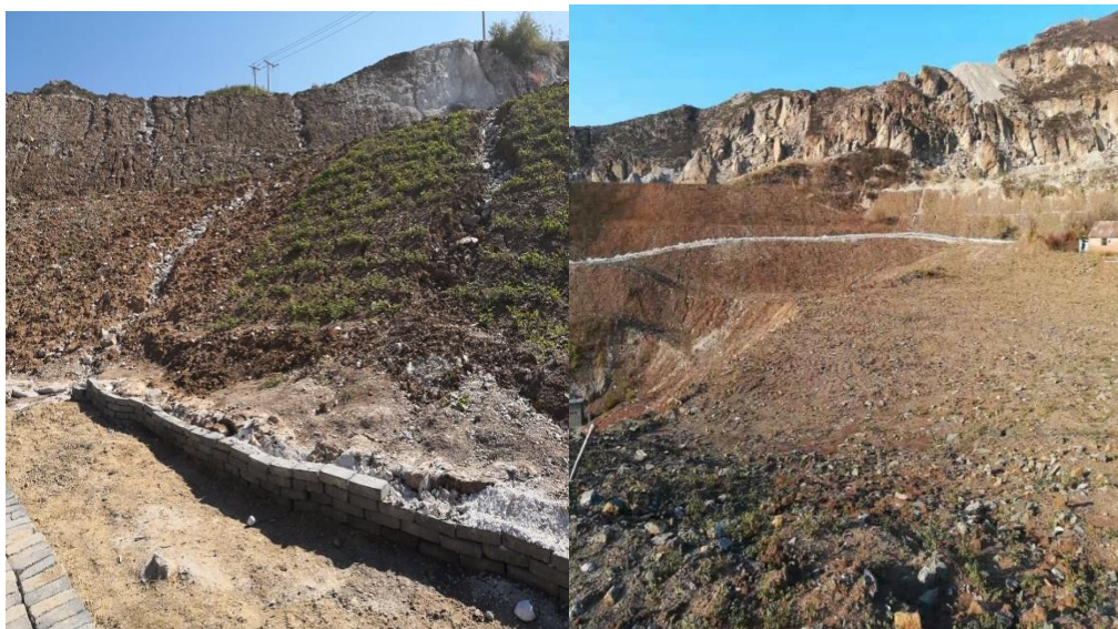
露天边坡防治区边坡修整及挡土墙
