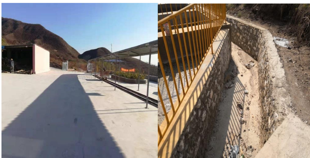
运输道路、工业场地防治区地面硬化、挡土墙及排水沟
