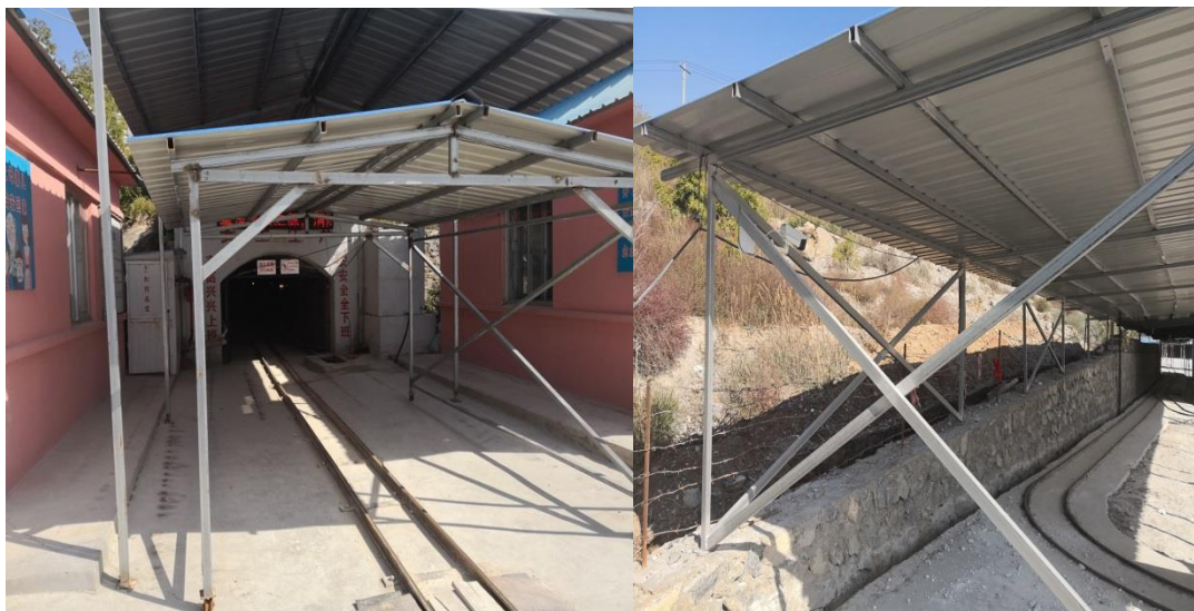
地下开采井口防治区挡土墙及排水沟
