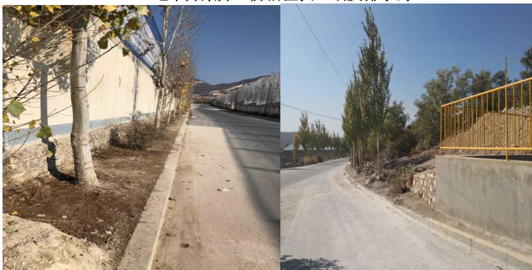
地下开采井口防治区挡土墙及排水沟
